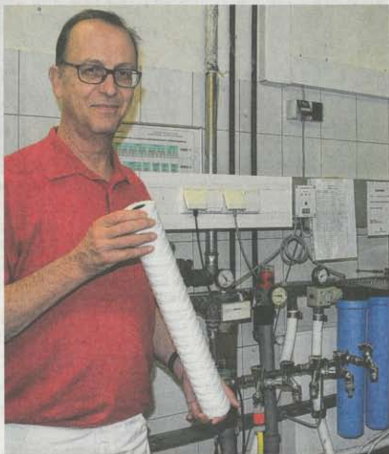
Dr. Klaus Gondolf vor den Filtern der Umkehrosmoseanlage. In der Hand hält er einen Aktivkohlefilter, der das Chlor aus dem Wasser ziehen soll. BILD: BALDUF
